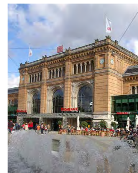
Die ECE verfügt auch über Expertise bei der Revitalisierung von Verkehrsimmobilien, was sie unter anderem beim Hauptbahnhof Hannover unter Beweis stellte.
