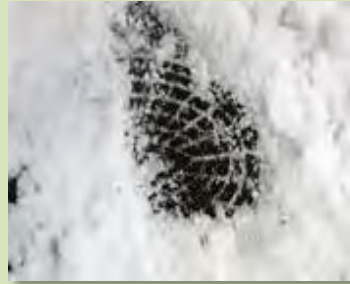
Abb. 31: Zugeschneiter und vereister Löschwasserhydrant [Quelle: ikl]
