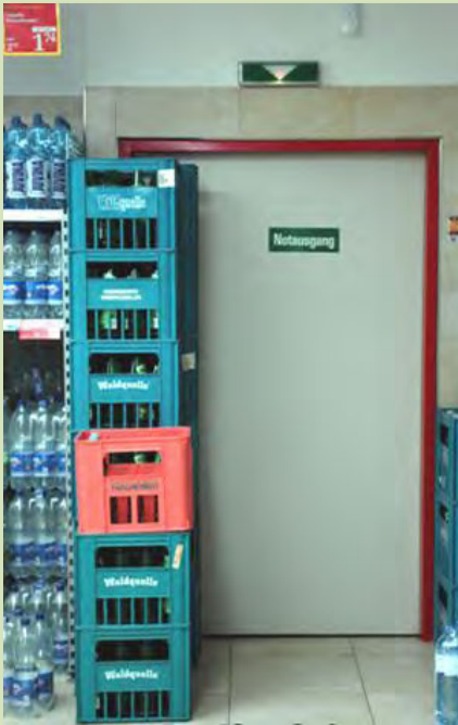
Abb. 30: Versperrter Notausgang [Quelle: ikl]
